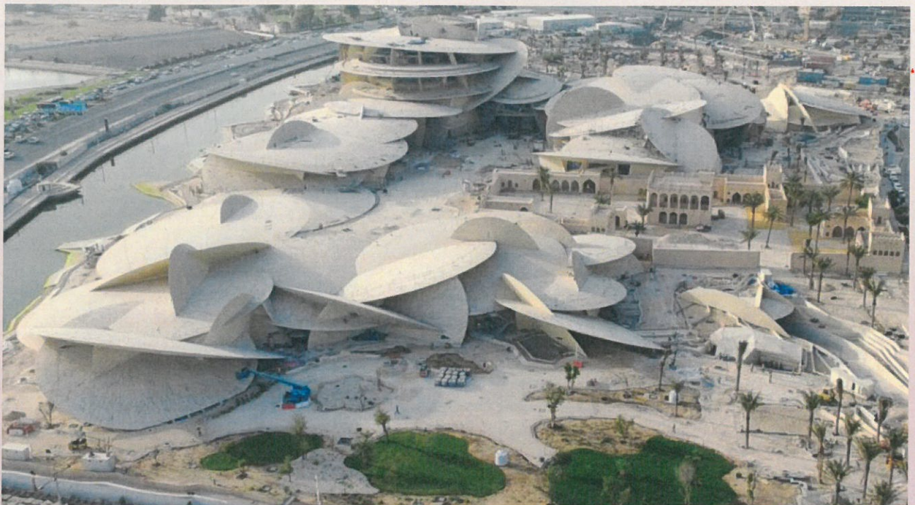
建設中のカタール国立博物館
