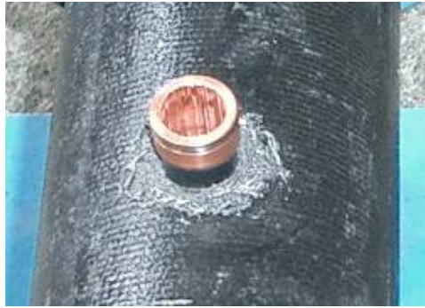
密着コア設置完了
