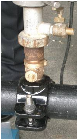
穿孔機取付状況
