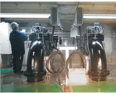
効果を発揮した排水ポンプ
