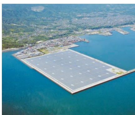
メガソーラー発電所
