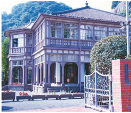
構成資産の一つ 旧鹿児島紡績所技師館
