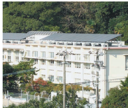
喜入小学校の屋上に設置したソーラーパネル
