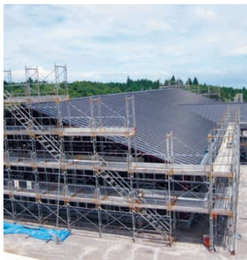
建設中の交流体験館
