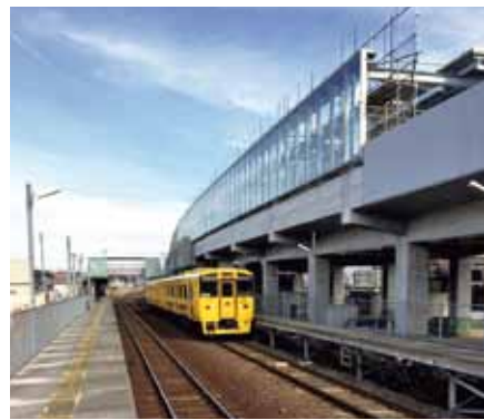
高架化工事が進む慈眼寺駅
