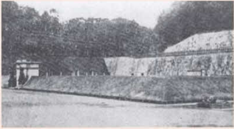
鹿児島島の古い配水池の一つ・上之原配水池
