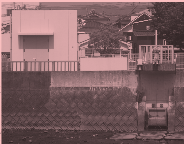
▶ 東塩屋第2雨水ポンプ場
