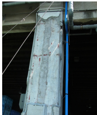
■ 老朽化の状況
