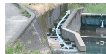
大城戸井堰の魚道
