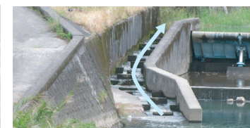
大城戸井堰の魚道
