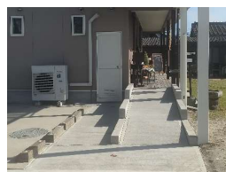
バリアフリー改修への支援 (階段をスロープへ)
