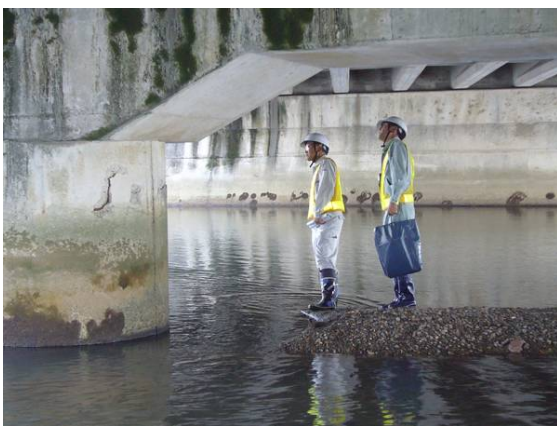
定期点検（概略点検：遠望目視）
