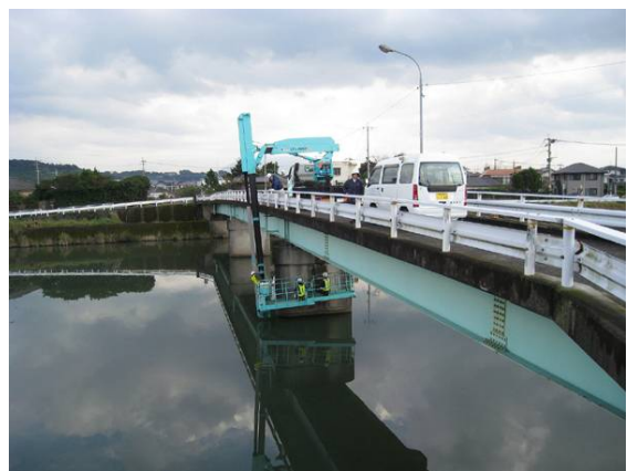
定期点検（詳細点検：近接目視）
