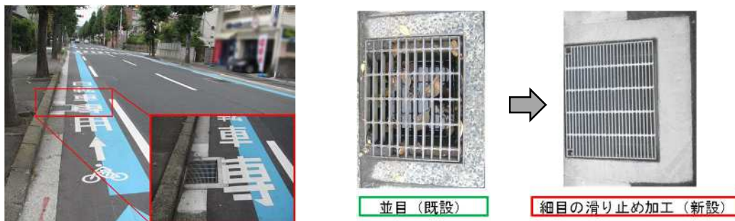
図 3.9 グレーチング蓋の格子の形状を工夫した事例
