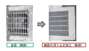
図3.9 グレーチング蓋の格子の形状を工夫した事例
