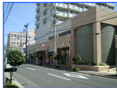
⑥ 外観(中央部)
