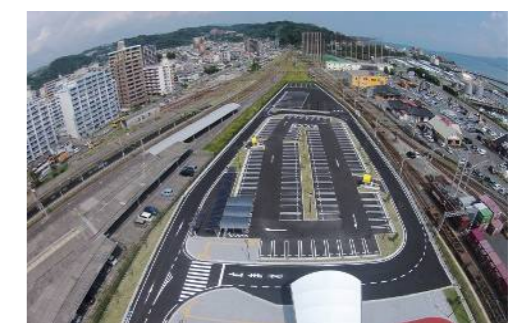
◇都市再生整備計画事業 【地域生活基盤施設】 鹿児島駅周辺都市拠点総合整備事業(駐車場)
