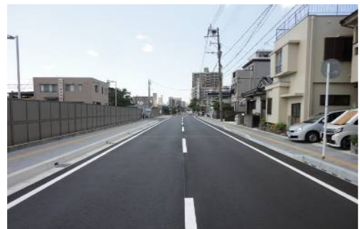
◇都市再生整備計画事業 【道路】鹿児島駅周辺都市拠点総合整備事業 (上本町磯線道路改良)
