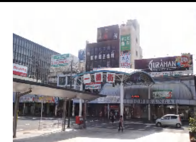
中央町19・20番街区(現況)
