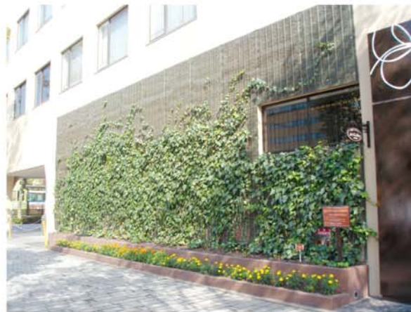
壁面緑化の状況
