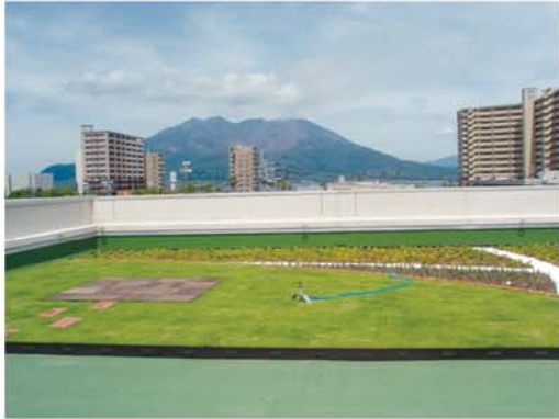
屋上緑化の状況
