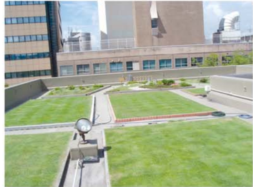
屋上緑化の状況
