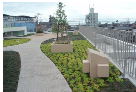
【屋上緑化施工事例】
