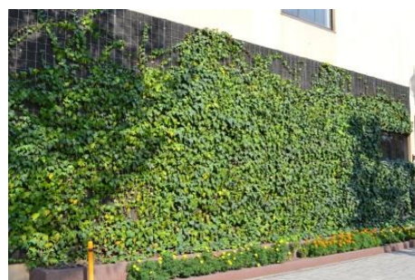
【公共施設の壁面緑化】 (市役所みなと大通り別館)
