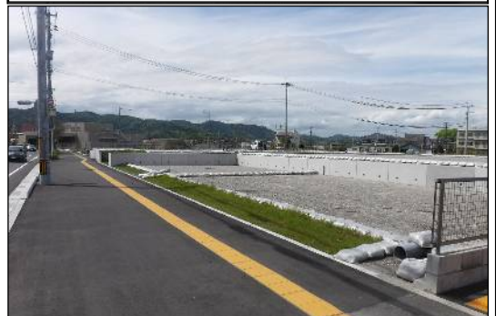
宅地整地の工事を進めています。
