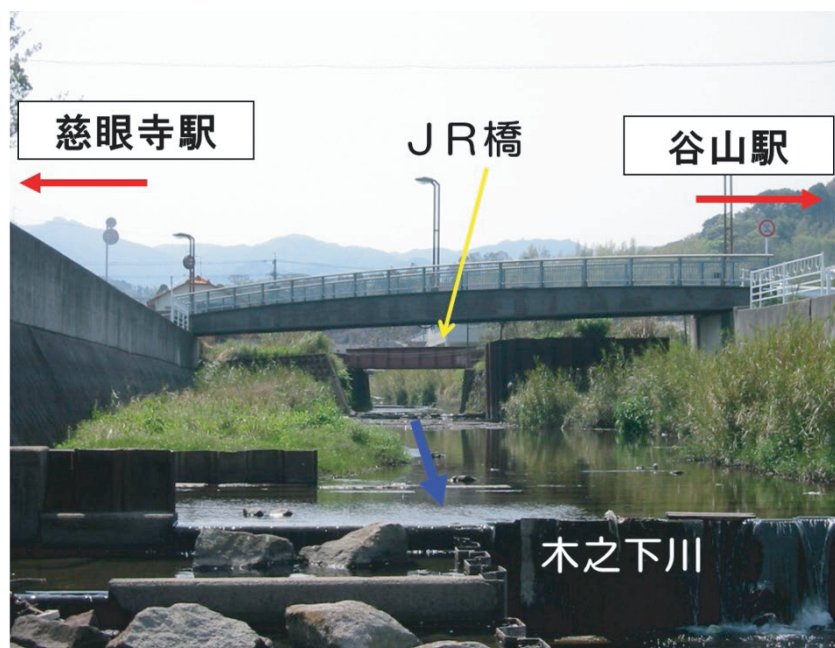
写真 3-1 高架化前の木之下川 JR 鉄橋
