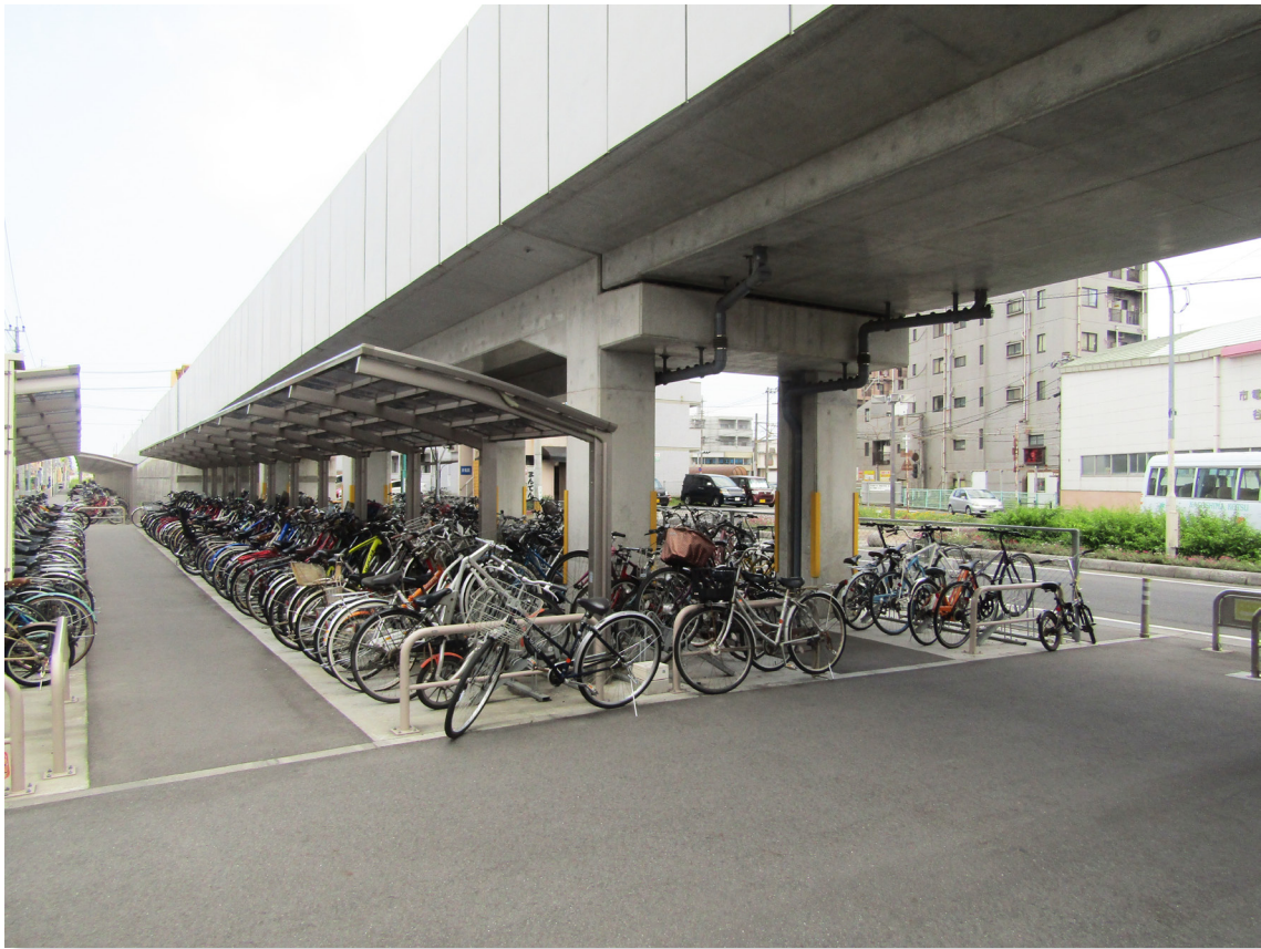
高架下駐輪場
