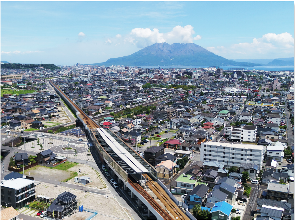
慈眼寺駅付近から谷山駅方面を望む
