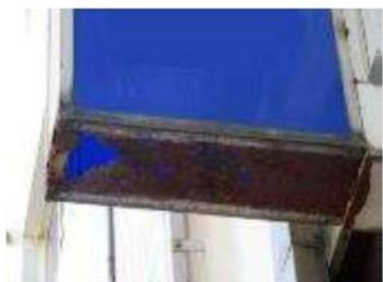
側板底面が腐食、破損した状態
