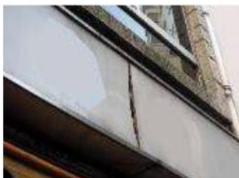
表示面板が変形（たわみ）し、継ぎ目に隙間が生じた状態
