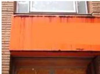
側板の腐食が進行した状態
