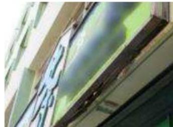
側板底面が破損した状態
