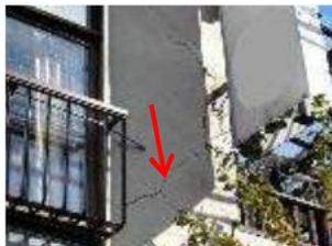
壁面にひびが生じた状態
