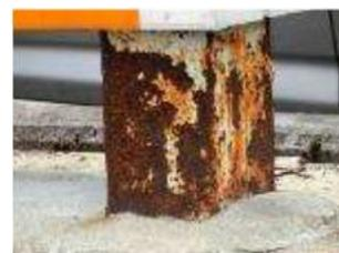
支柱根元の腐食が進行した状態
