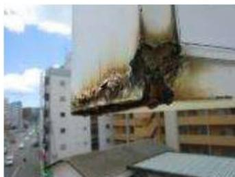
側板の腐食が進行した状態
