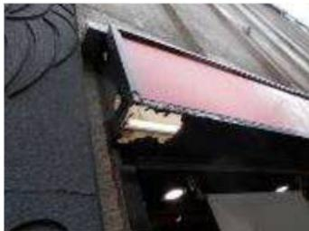
側板底面の腐食が進行した状態
