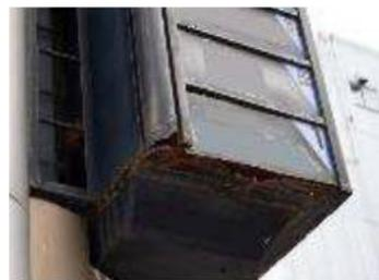
側板底面が腐食、破損した状態
