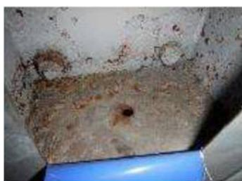
ブラケットの腐食が進行し、劣化した状態
