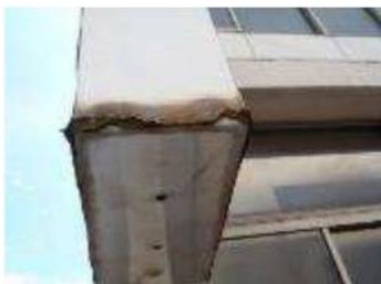
側板の腐食が進行した状態
