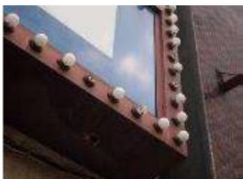
ランプ球が破損した状態
