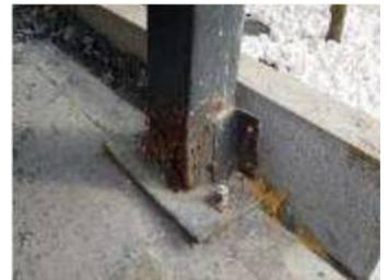
支柱根元の腐食が進行した状態
