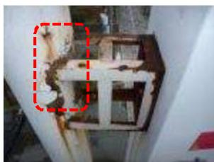
取付部の溶接部が劣化している状態
