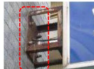
取付部プレートが腐食している状態
