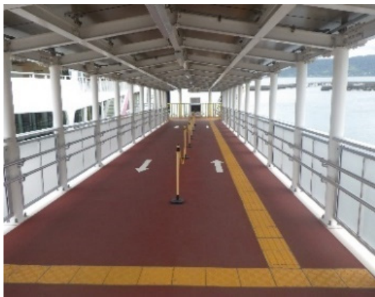
桜島港フェリー乗降施設（人道橋）の整備 (中央地区：令和元年度整備箇所)
