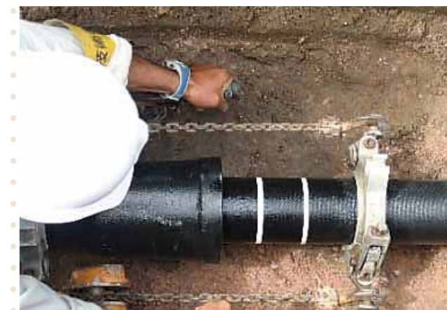
水道管(耐震管)の布設
