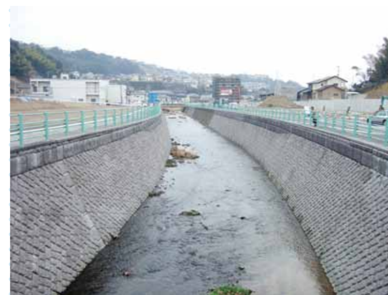
脇田川護岸整備
