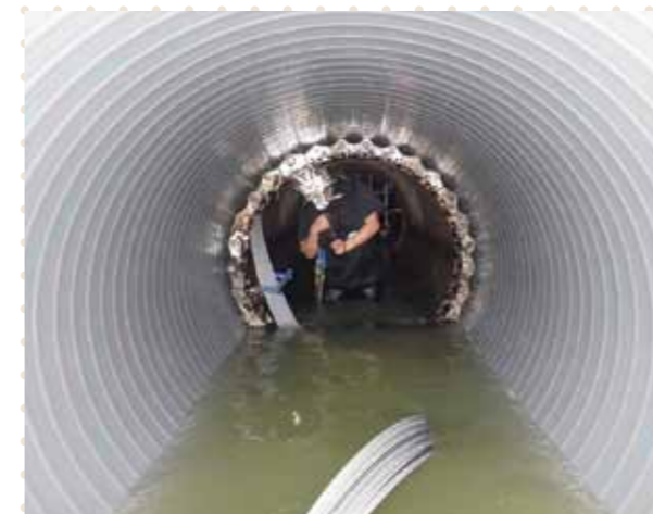
管更生工法による汚水管の長寿命化
