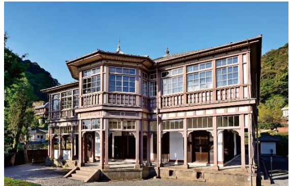
旧鹿兒島紡績所技師館（異人館）
