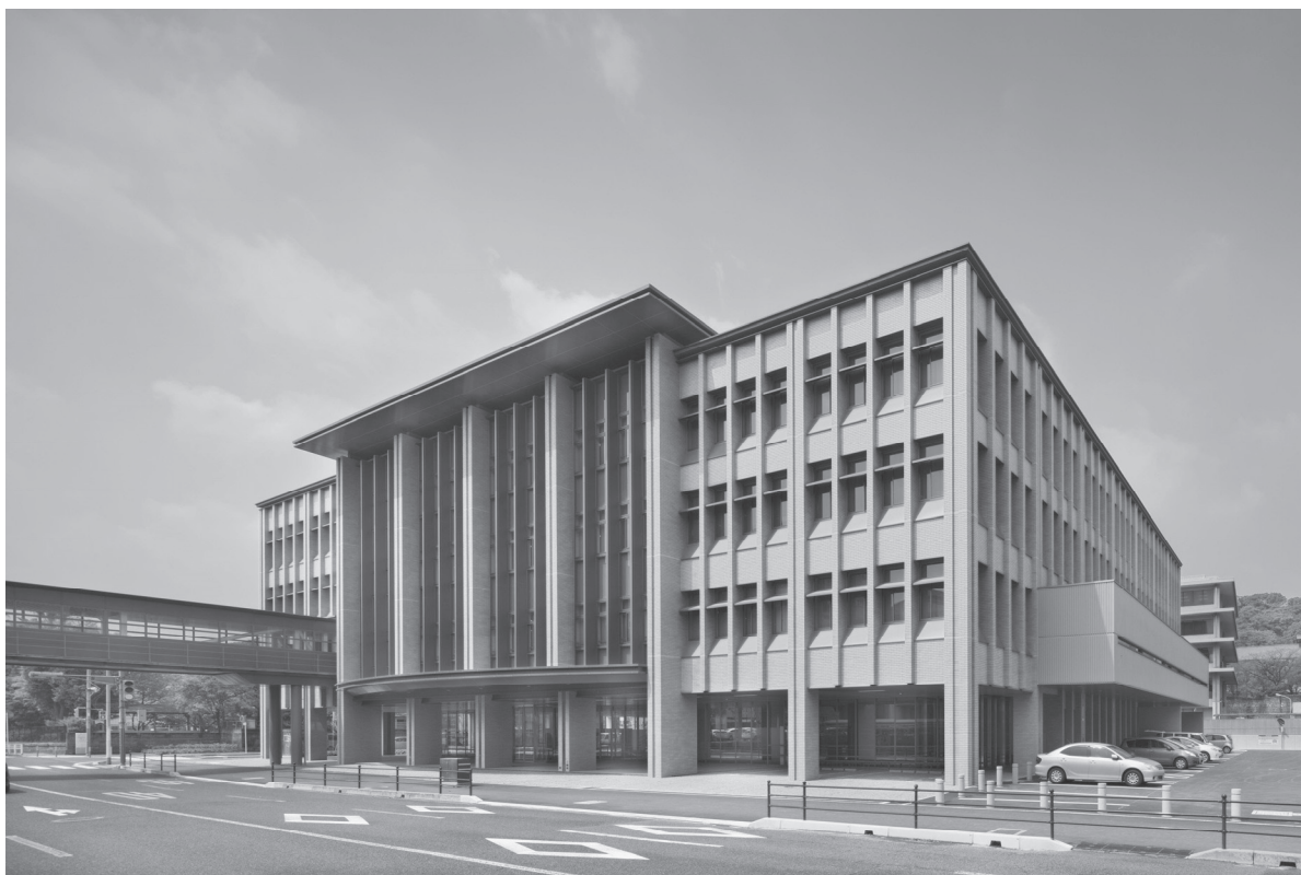
鹿児島市役所本庁舎の整備（西別館）
