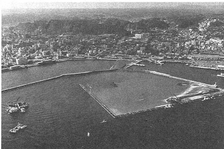
着々と進む本港改修工事＝平成元年11月5日＝
