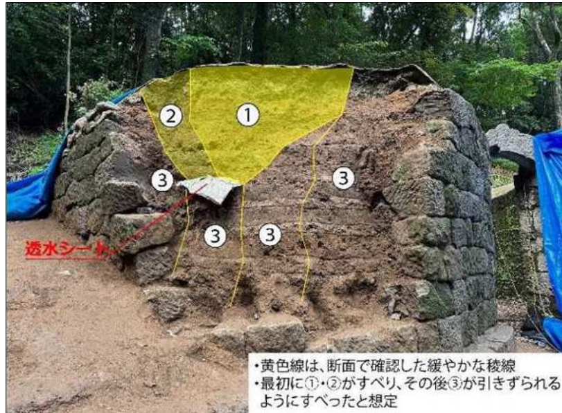
図2 新規盛土崩壊形態模式図
