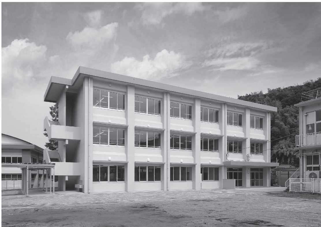
松元小学校校舎増築（平成30年8月10日竣工）
