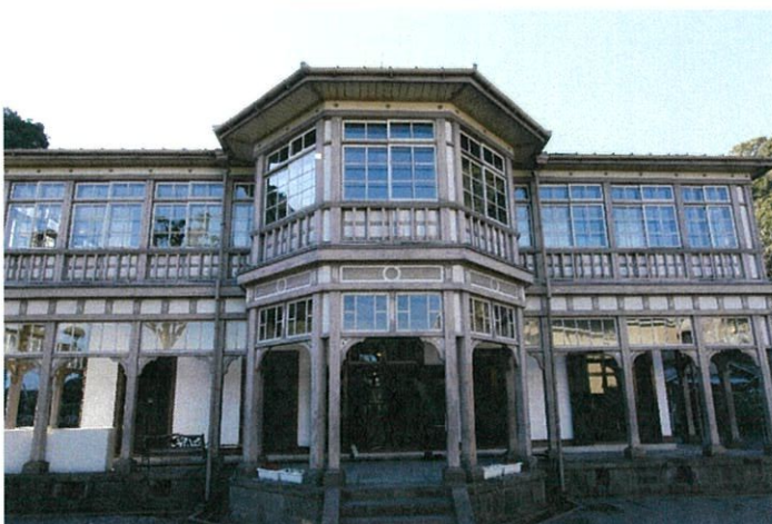
旧鹿児島防鑄所技師館（異人館）
