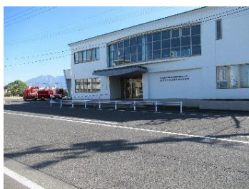
④ 市消防総合 訓練研修センター
