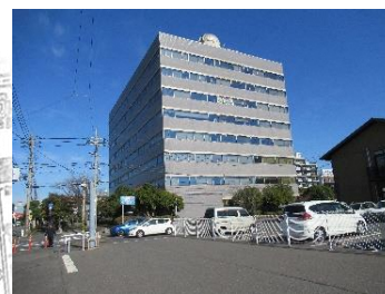
⑤ 鹿児島第2地方合同庁舎
