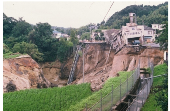
国道3号線(河頭地区)の被害状況
