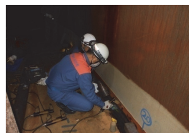
石油タンク内部検査の実施
