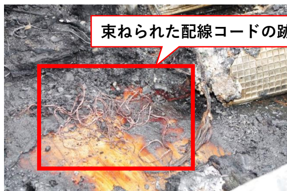
【火災現場のコードの様子】
