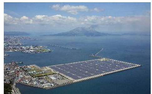
鹿児島七ツ島メガソーラー発電所
