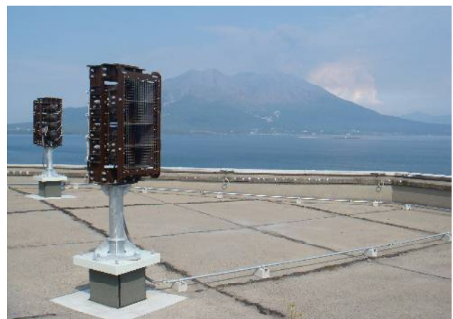
屋外スピーカ（市民文化ホール屋上）
