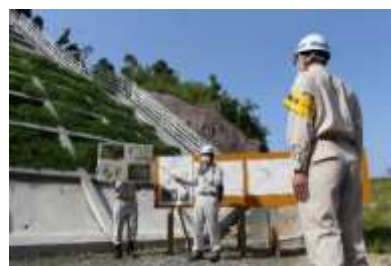
昨年の点検箇所「名突地区急傾斜地崩壊対策工事(伊敷7丁目)」
