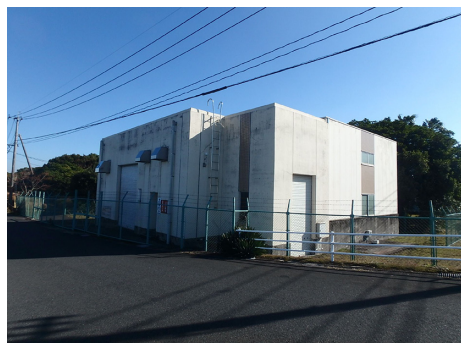
和田地区排水機場
