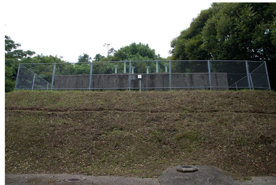
一倉工水配水池
