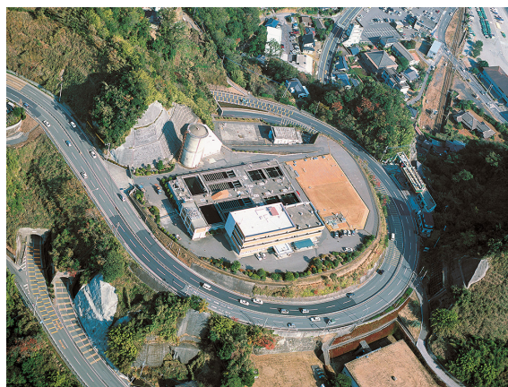
滝之神浄水場
