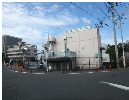
真砂雨水ポンプ場
