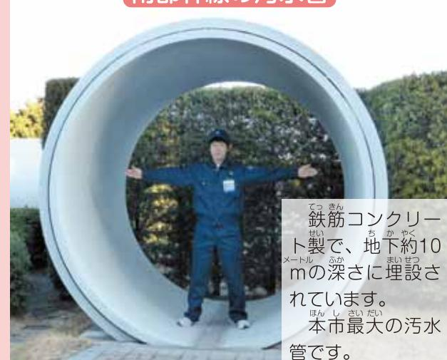
鉄筋コンクリート製で、地下約10mの深さに埋設されています。
