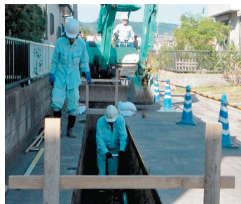
【汚水管の布設工事】 事業計画区域において、汚水管の整備を進めるとともに、既設管の老朽化対策に取り組んでいます。
