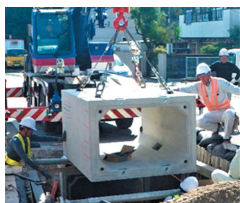
【雨水管きよの布設工事】 浸水被害の軽減を図るための布設替えや既設管きよの老朽化対策を進めています。
