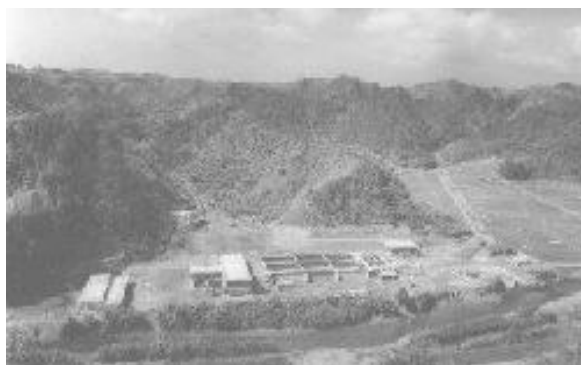
図2-1 完成した河頭浄水場全景(第1期工事(昭和42年3月))
