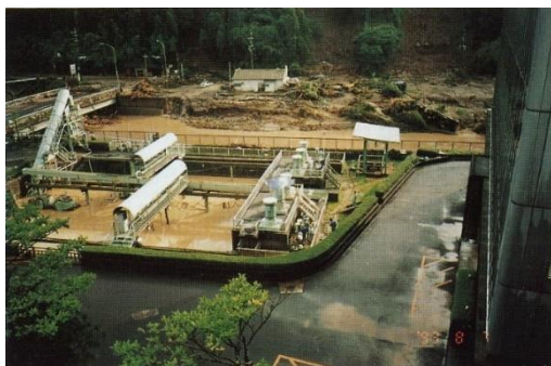
図3-5 冠水した河頭浄水場
