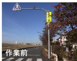
作業前 標識にかかる高木
