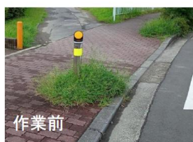
作業前 車止め周辺の雑草
