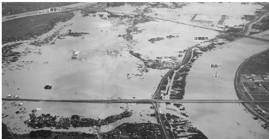
長良川右岸、大森地先の堤防決壊による浸水状況（岐阜県安八郡安八町・大垣市墨俣町）
