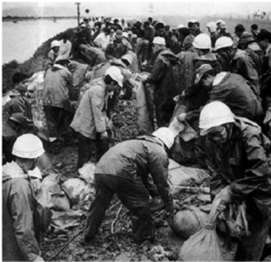
長良川左岸・水防団による水防活動（岐阜市鏡島）
