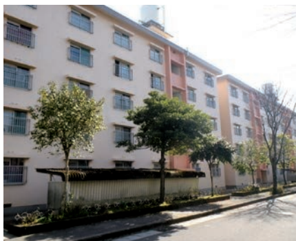
▲市営星ヶ峯住宅
