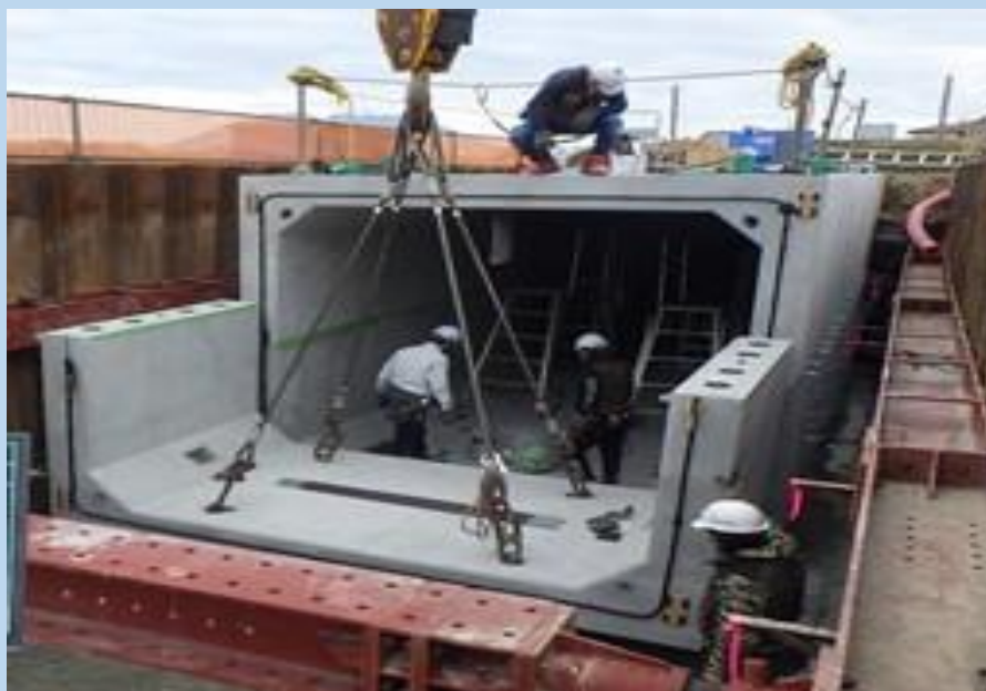
▶ 雨水管きよの整備
