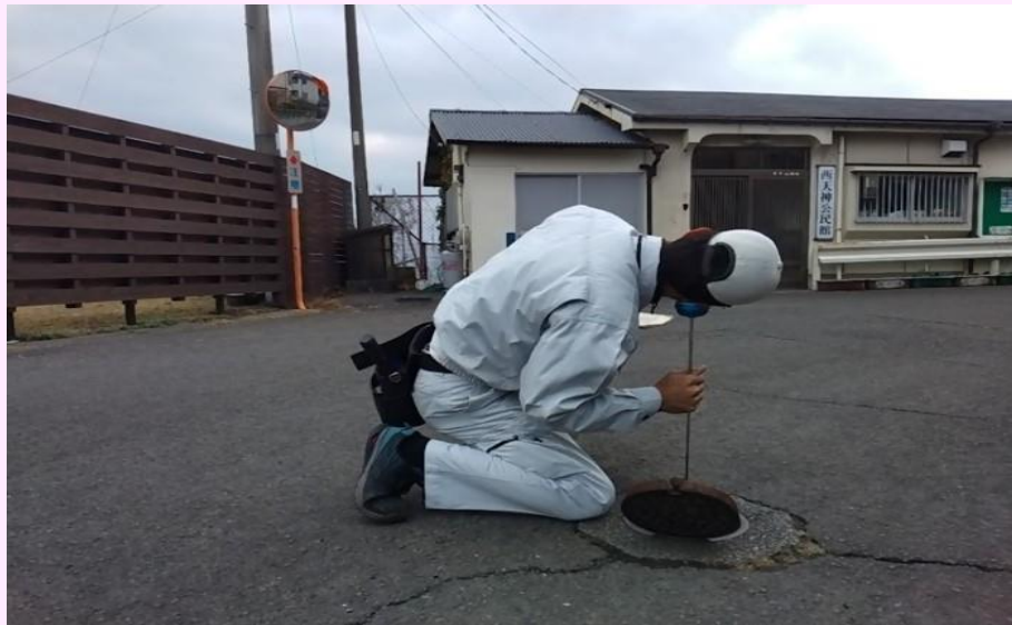
▶ 水道管の漏水調査
