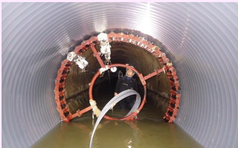
▶ 下水道管の改築
