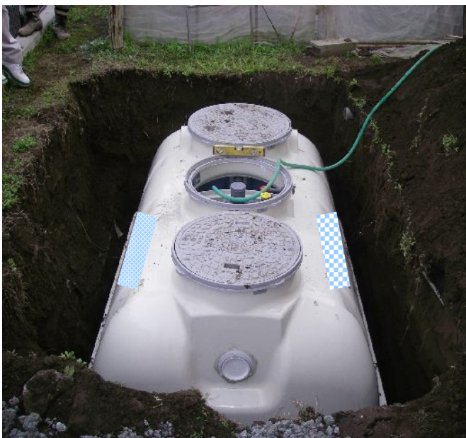
浄化槽の整備
