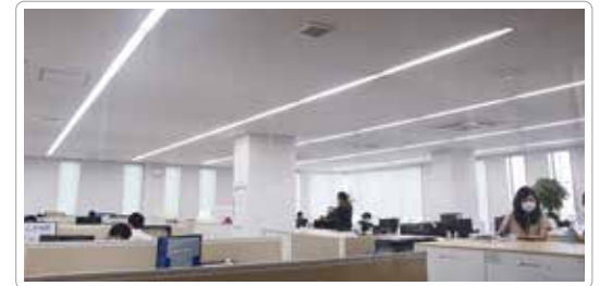
全てついた状態のフロア照明
