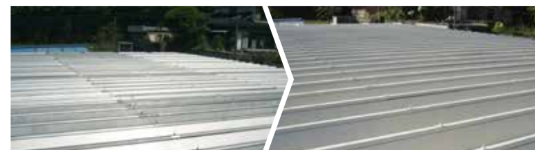
省エネ塗装をする前の屋根
