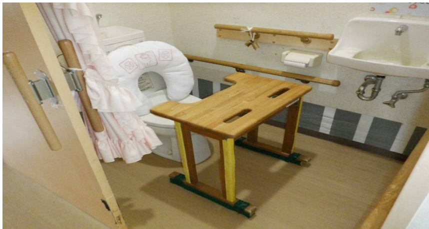
図 2: トイレテーブル設置例
