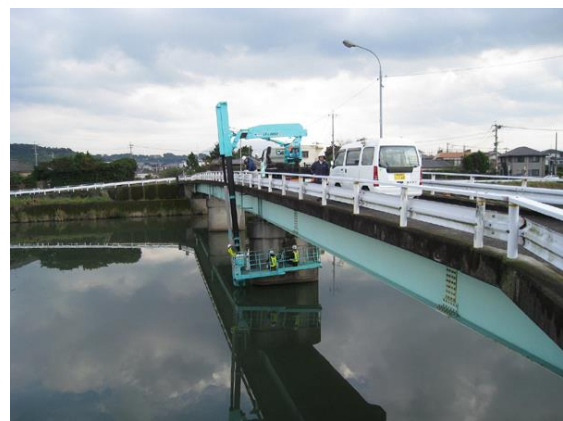
定期点検（近接目視）：橋梁点検車
