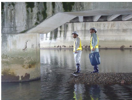
定期点検（近接目視）：徒歩点検
